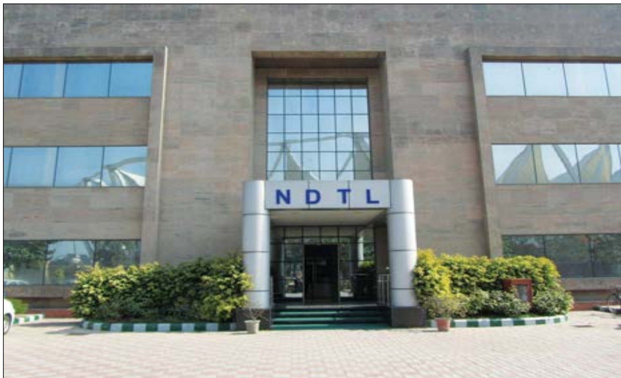
आकृति – 1 एन.डी.टी.एल भवन, जेएलएन स्टेडियम, दिल्ली, भारत
